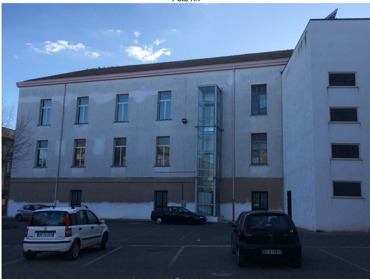
Foto n.8 – Vista prospetto Sud
