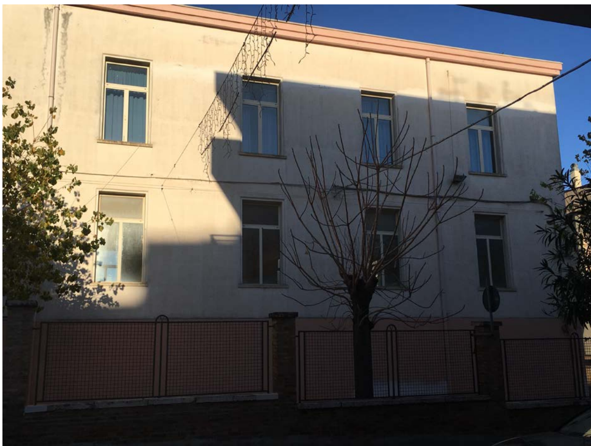
Foto n.5 – Vista prospetto Ovest
