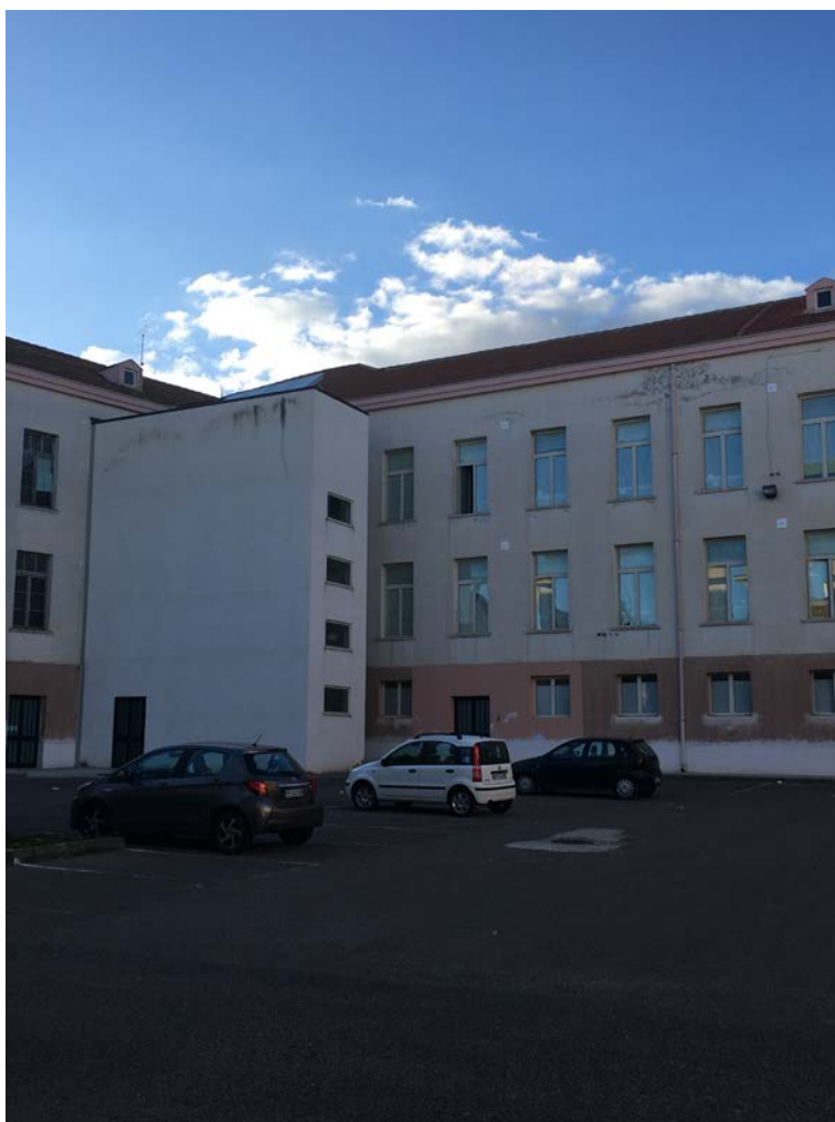
Foto n.9 – Vista prospetto Sud
