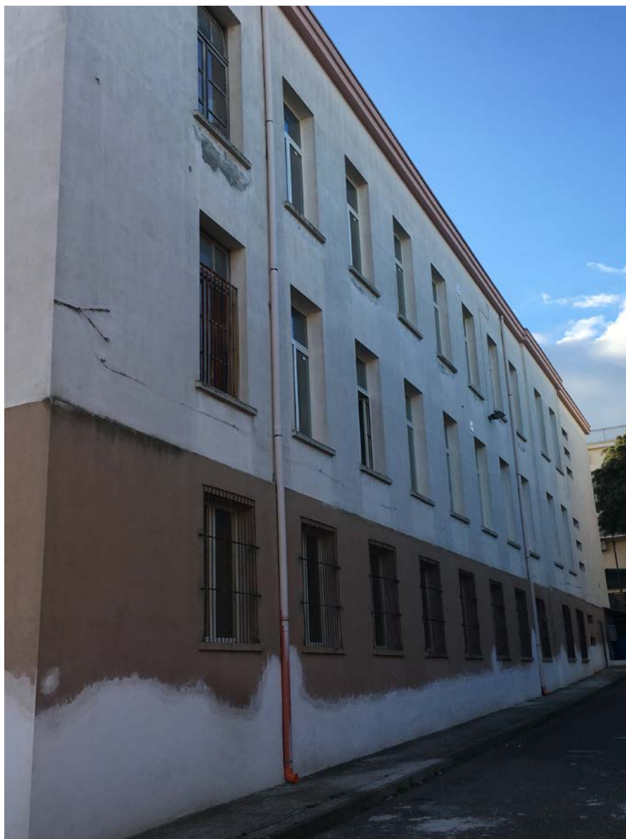
Foto n.11 – Vista prospetto Est
