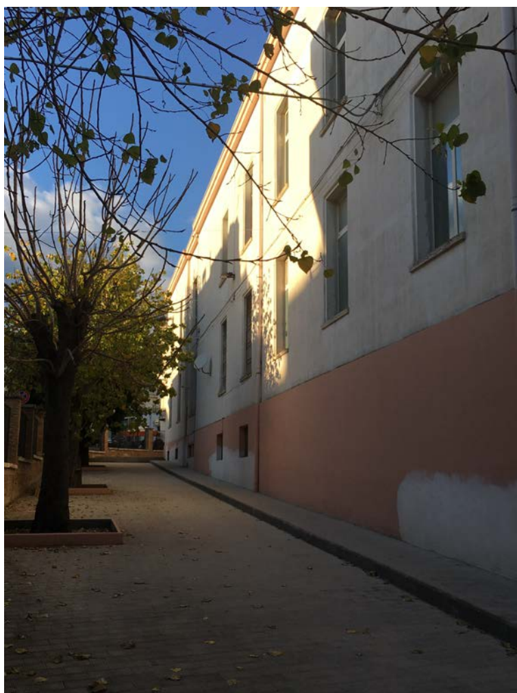
Foto n.4 – Vista prospetto Ovest
