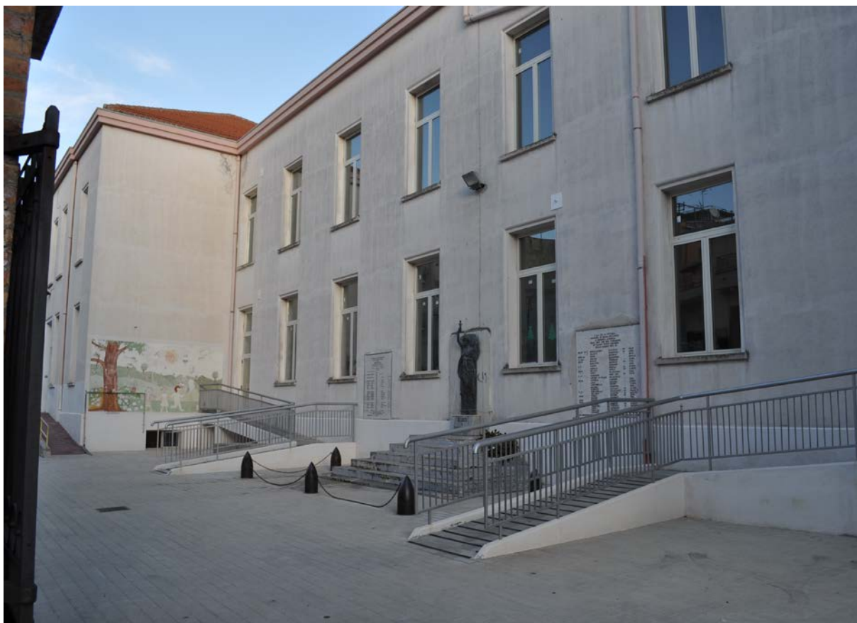
Foto n.1 – Vista prospetto Nord
