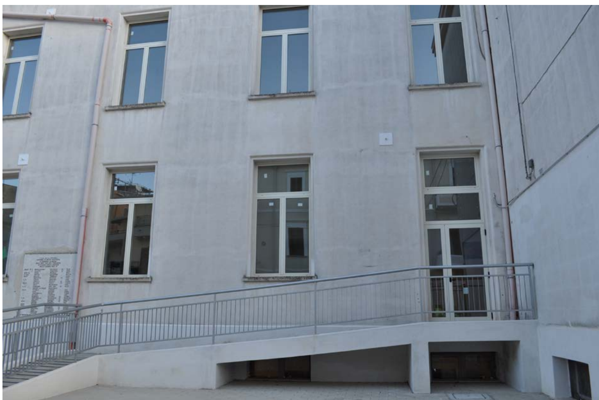
Foto n.2 – Vista prospetto Nord
