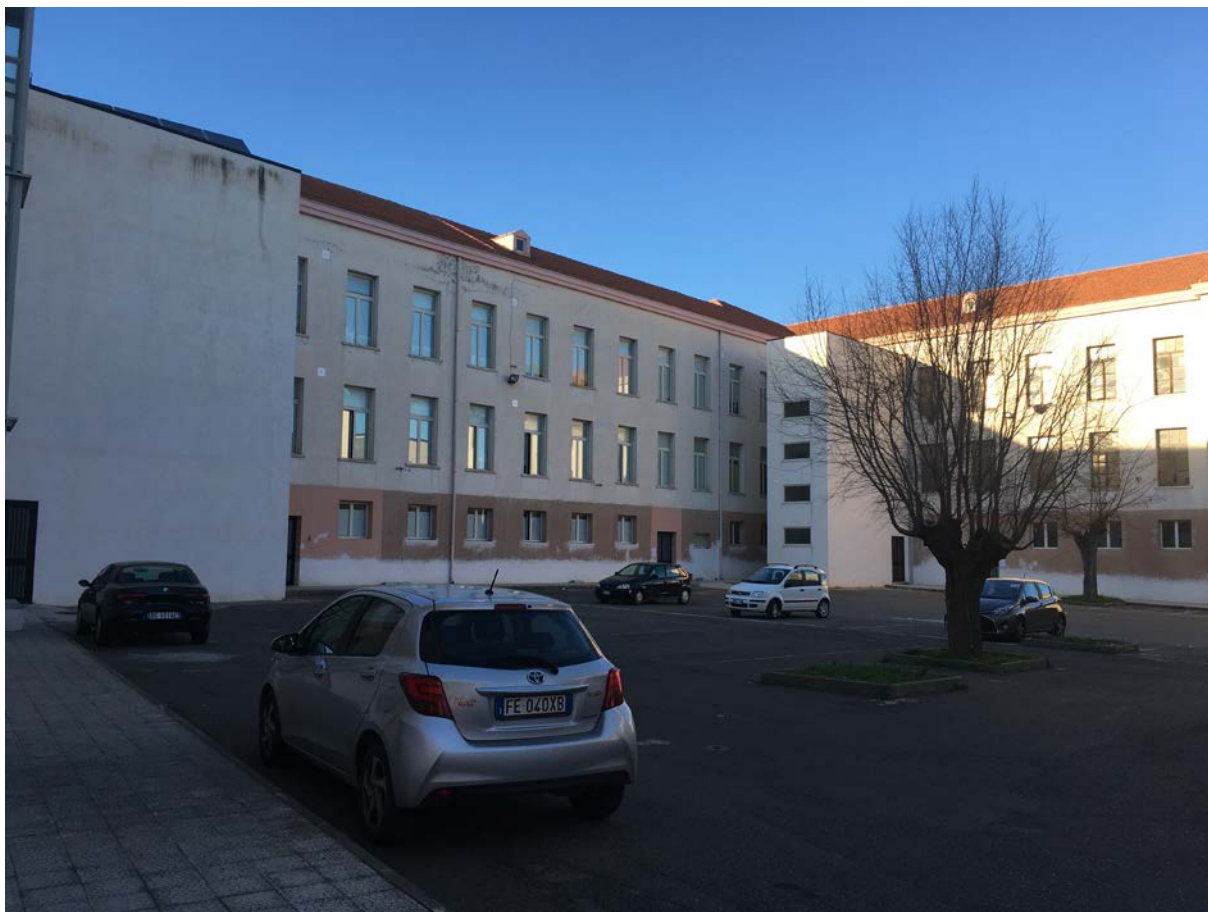
Foto n.6 – Vista prospetto Sud
