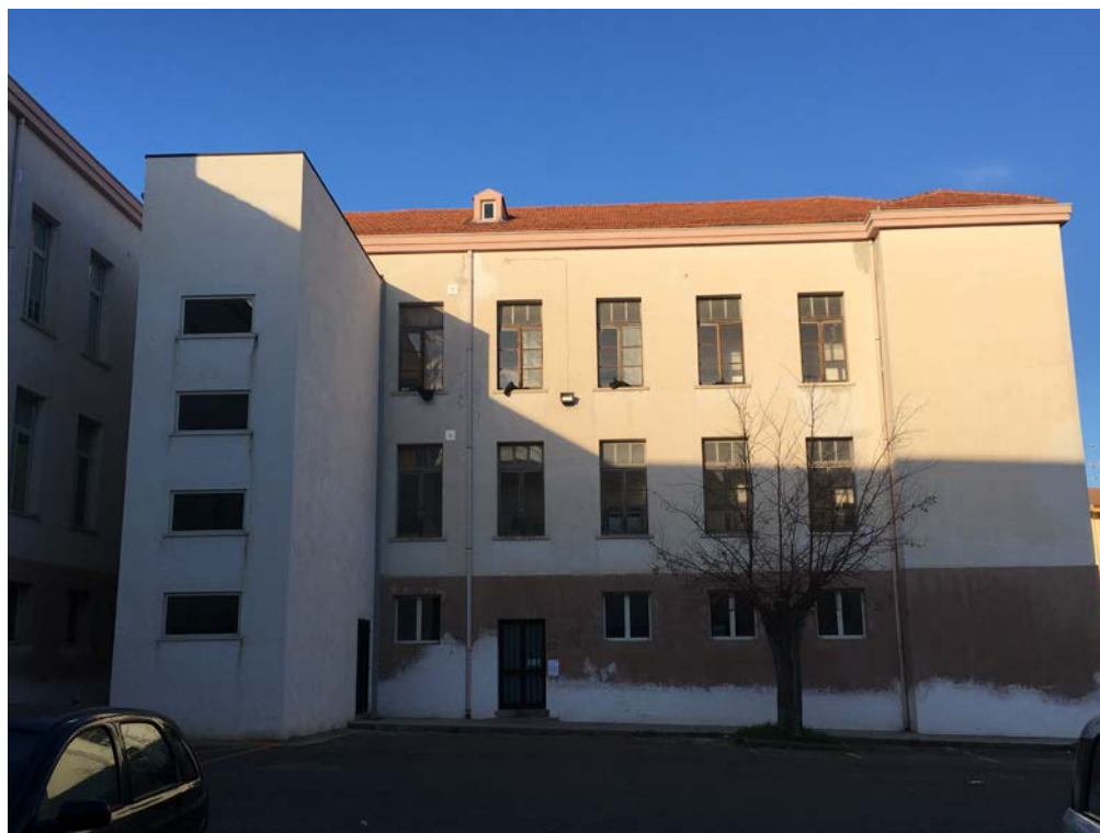
Foto n.10– Vista prospetto Sud
